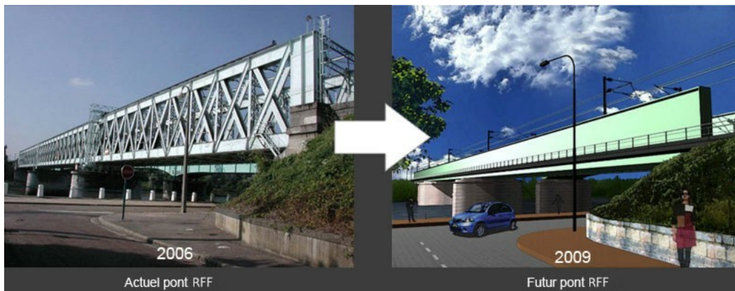
Exemple de changement de pont métallique à Oissel
