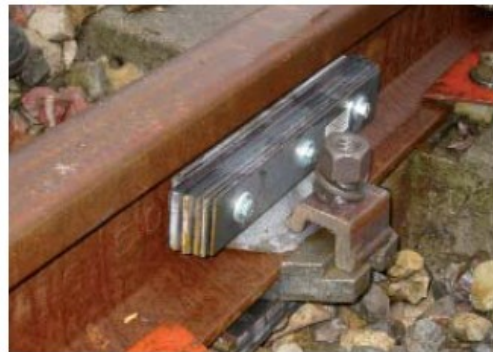
Exemples d'absorbeurs sur rail (Corus et Socitec)
