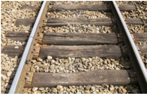
Rails courts sur traverses bois
